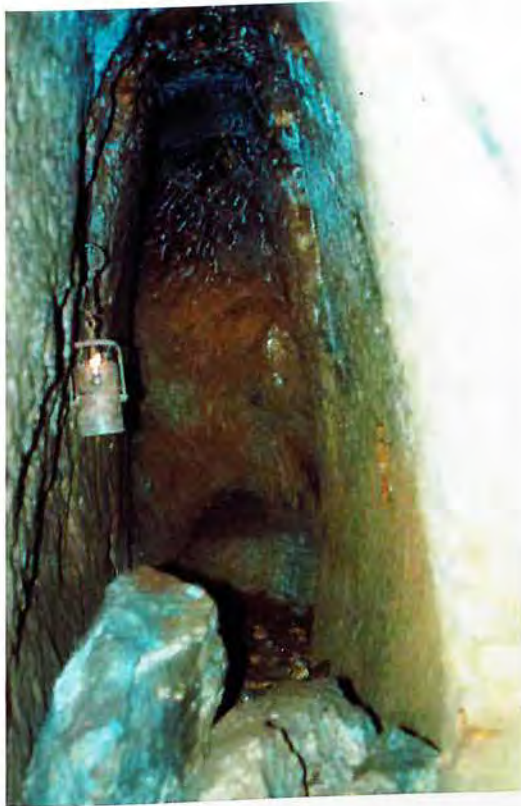
Ortsbrust im Christophstollen
