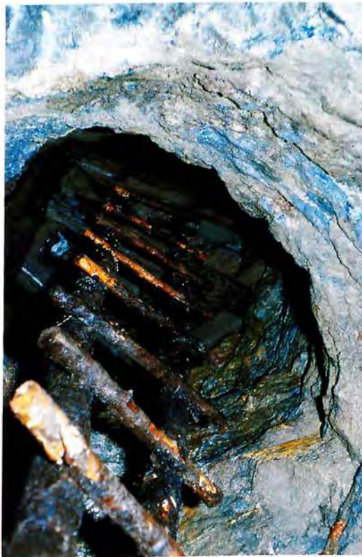
Fahrte zum Tiefbau im Schurfbau Vogelhalt
