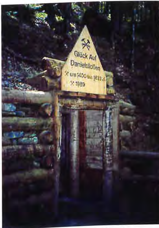
Mundloch des Danielstollens
