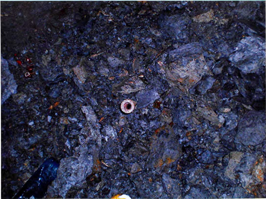
Rohr in der Sohle zur Erkundung des Gesenks
