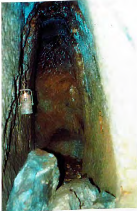
Ortsbrust im Christophstollen
