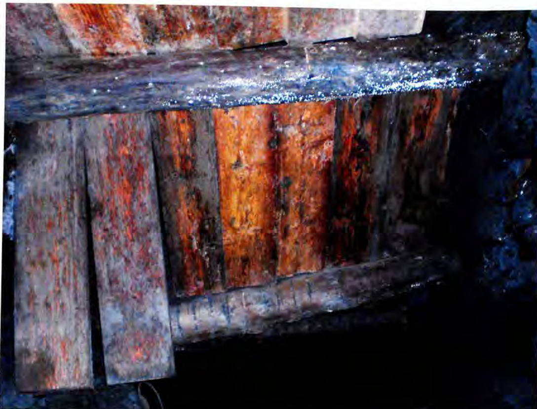
Absicherung der Firste
