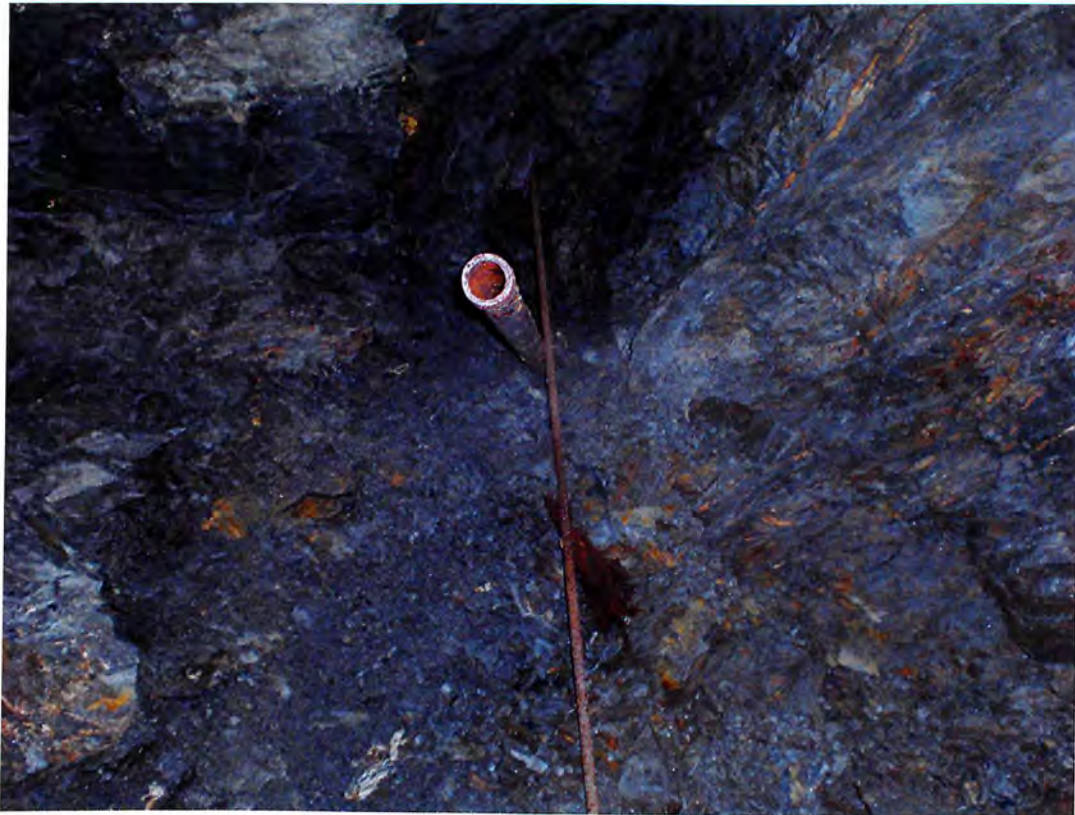
Am Ende des ausgeräumten Stollens ein Rohr an der Firste zur weiteren Erkundung des Stollenverlaufes
