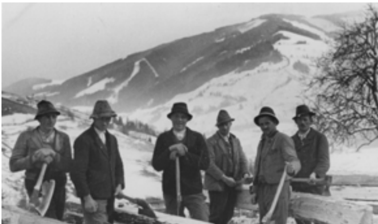
Das alte Bauernhaus Schrattenegg, der Rohbau 1938 und Zimmerer beim Aushacken der Trame für den Dachstuhl
