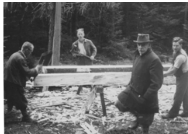
Der Schindelmacher und Zimmerer beim Aushacken der Balken für den Neubau des Bauernhauses auf Schrattenegg 1937
