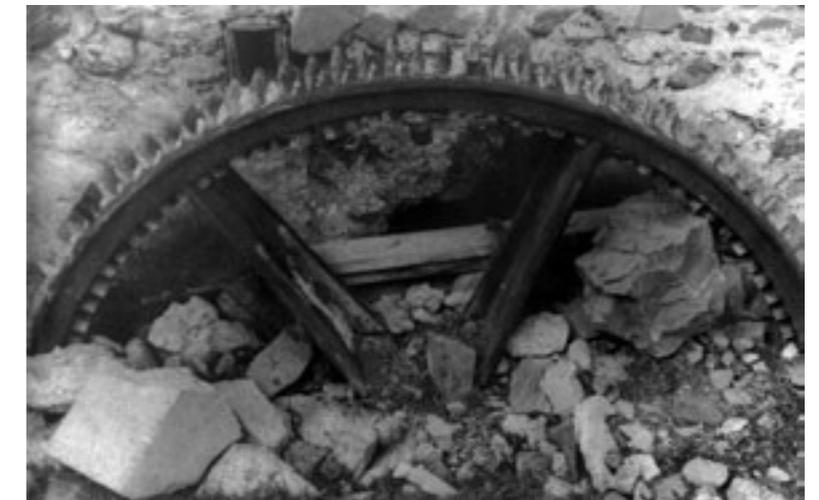
Zahnradantrieb der Schmiede nach Abriss
