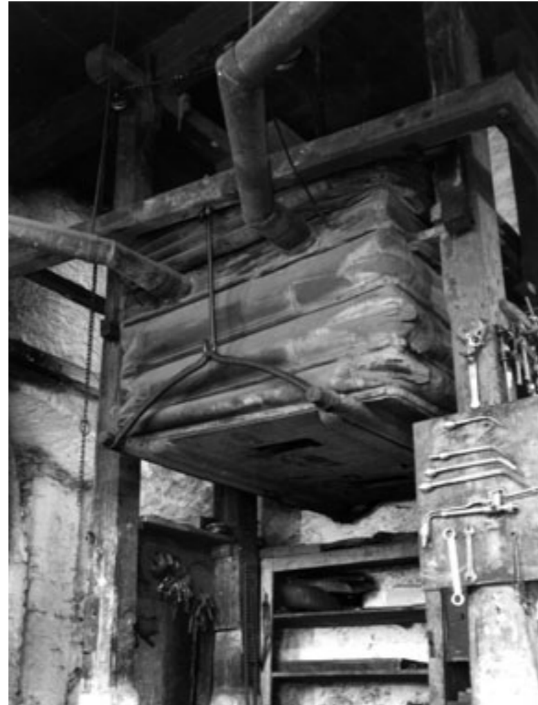
Der Blasbalg lieferte die nötige Luft für die beiden Essen. Er wurde durch die Wasserkraft des Mühlbaches angetrieben.
