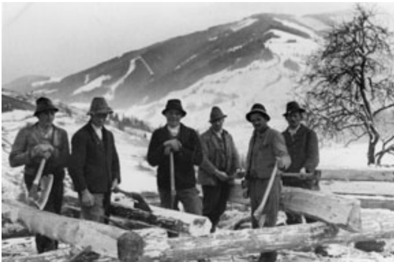
Zimmerer beim Bau des Schrattegg-Bauernhauses 1937
