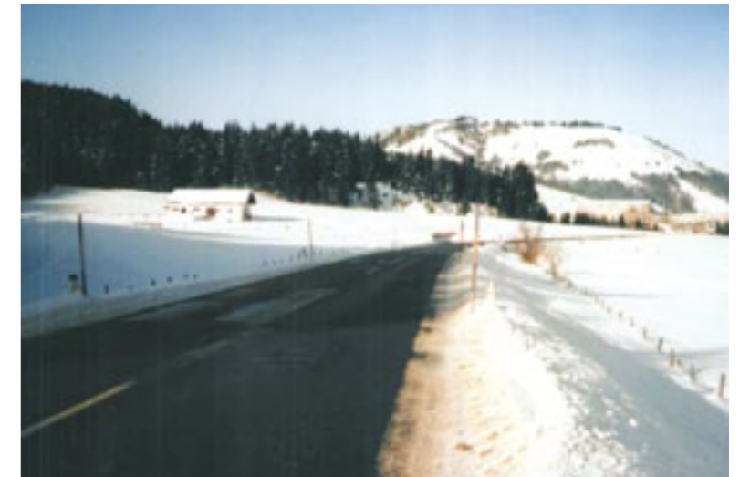
Neu trassierte Straße von Berg Griesen nach Hochfilzen
