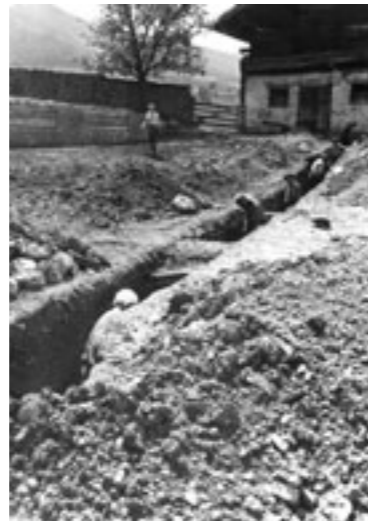
Die Wasserleitung wurde händisch gegraben, hier zum Wirtsstall 1955
