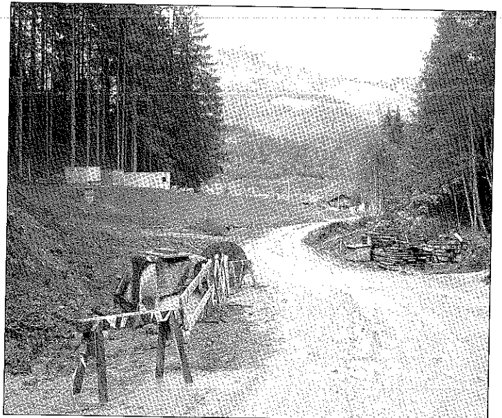
Das neue Straßenstück im Bereich der Sperre wurde bereits aufgeschüttet.
