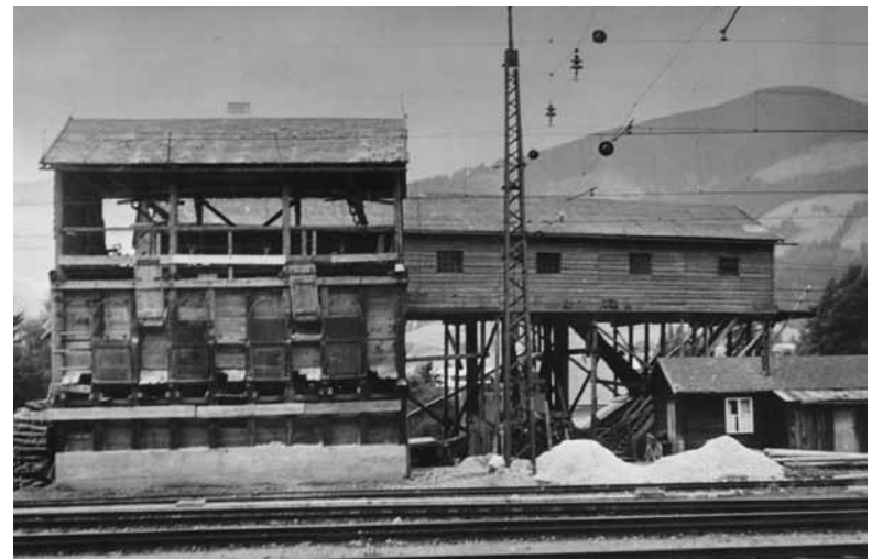
Verladestation am Bahnhof Leogang (bis 1973)
