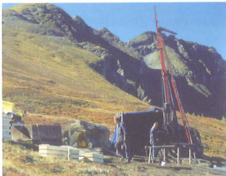
Bergbau Schellgaden, Kernbohrung am Kareckrücken (1995)
