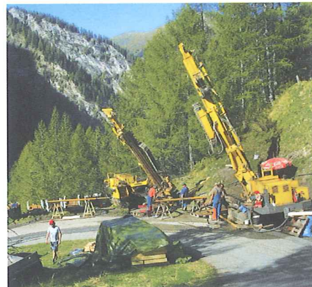
Bergbau Rotgülden, Bohrarbeiten unterhalb Rotgüldensee, Firma Noricum Gold, 2011
