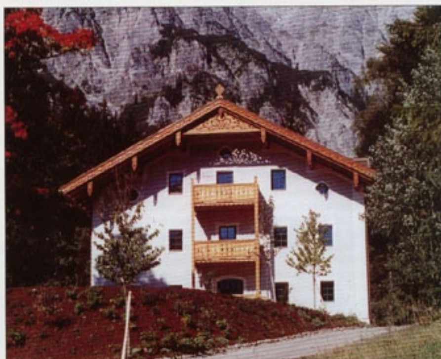
Wunderschön erstrahlt das renovierte Badhaus in neuem Glanz. Allein die Fassadengestaltung liefert einen Beweis für die heimische Handwerkskunst.
