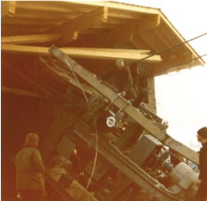
Abgestürzte Antriebsgruppe nach Seilriss des Spannungsgewichtes
