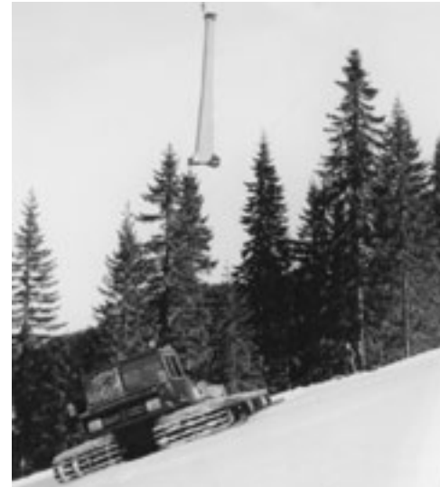
Stützenmontage mit dem Hubschrauber für die 2. Sektion der Asitzbahn 1972
