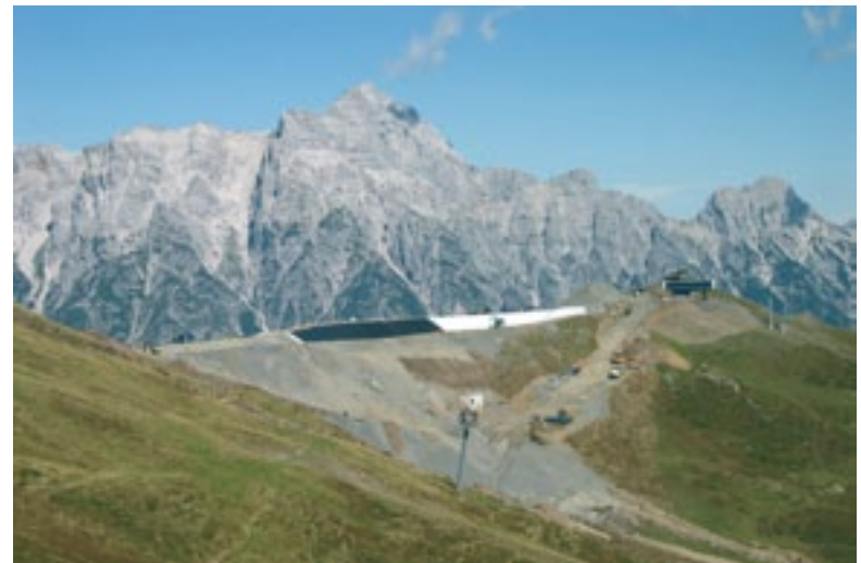
2004 Bau des Speichersees zwischen Kl. und Gr. Asitz
