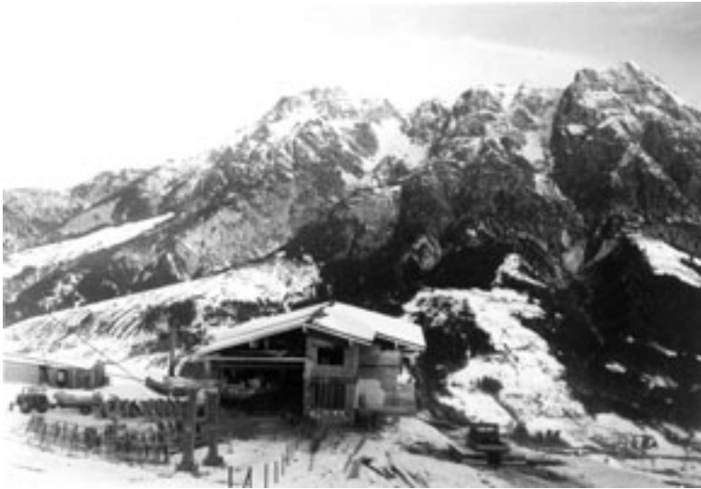
Bau der Talstation für die 2. Sektion der Asitzbahn 1972
