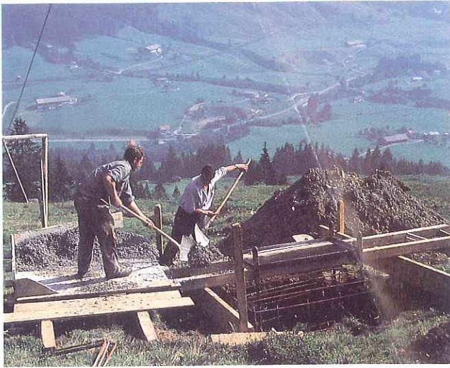
Arbeiten an der Talstation und an den Stützenfundamenten
