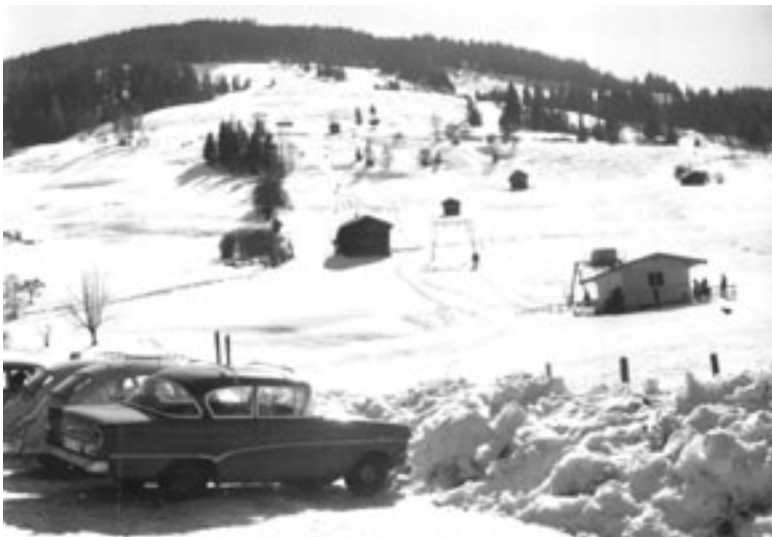
Wimbachlift errichtet 1965, rechts Pistenchef Obermadreit Zenzei
