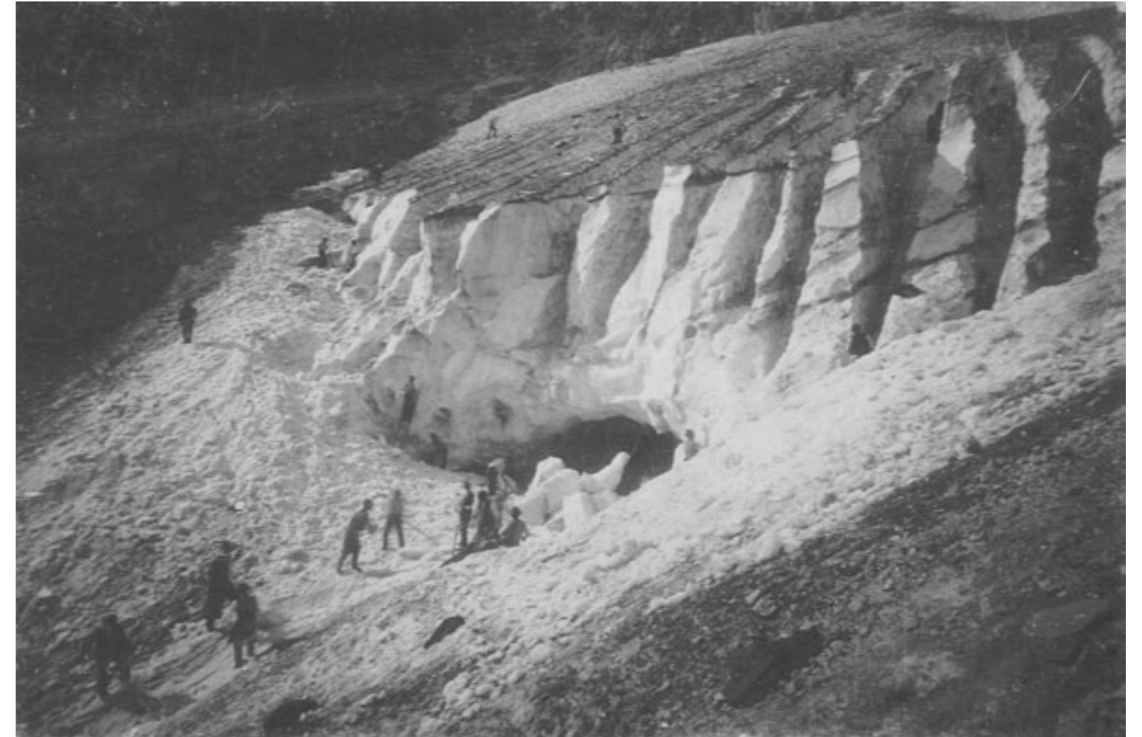
Dieses Bild zeigt ebenfalls die Abbaumethode mit Schlitzen
