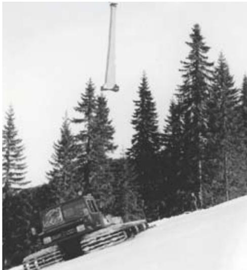
Stützenmontage mit Hubschrauber für die 2. Sektion 1973
