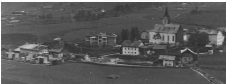
Das Dorf im Sommer 1940, das Haus des Bürgermeisters Empl ist im Bau
