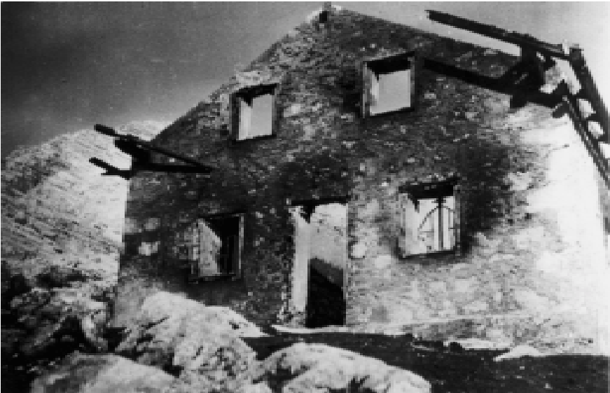
Passauerhütte nach dem Brand 1946
