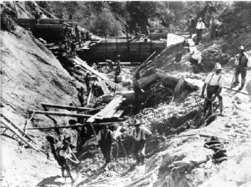
Bauarbeiten an der Eckersbach-Wehr 1937
