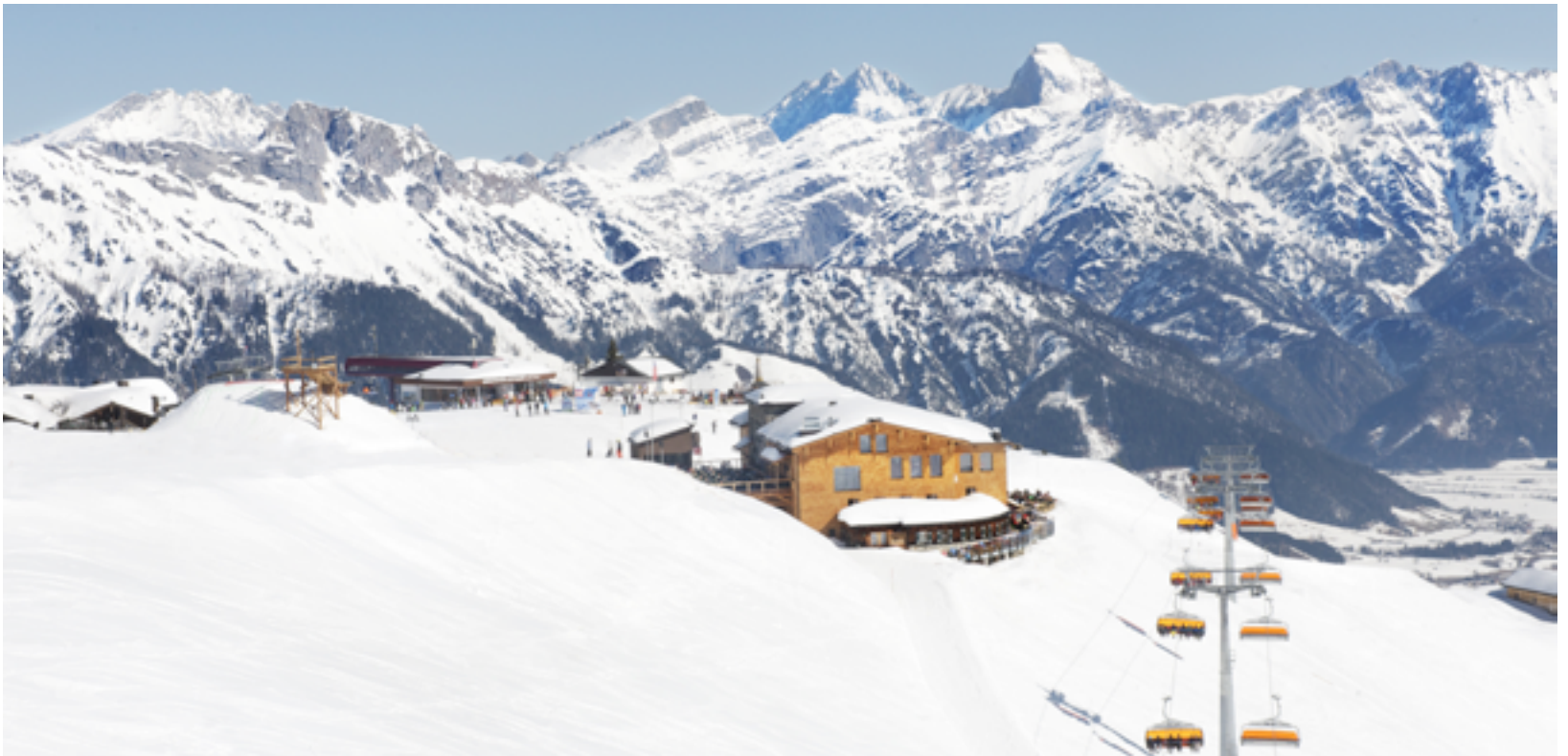
Asitzbräu mit Bergbahn-Bergstation und Alter Schmiede 2012. Der niedrige Anbau am Asitzbräu mit Terrasse stammt noch von der alten Asitzhütte.
